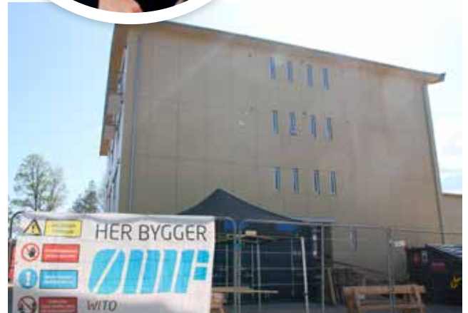
Sykehusstiftelsen i Winsnes gate i Kongsvinger er et av de større prosjektene ØMF Wito nylig har deltatt i som rammeavtalepartner med KOBBL. (Foto: Jan Tveita)
