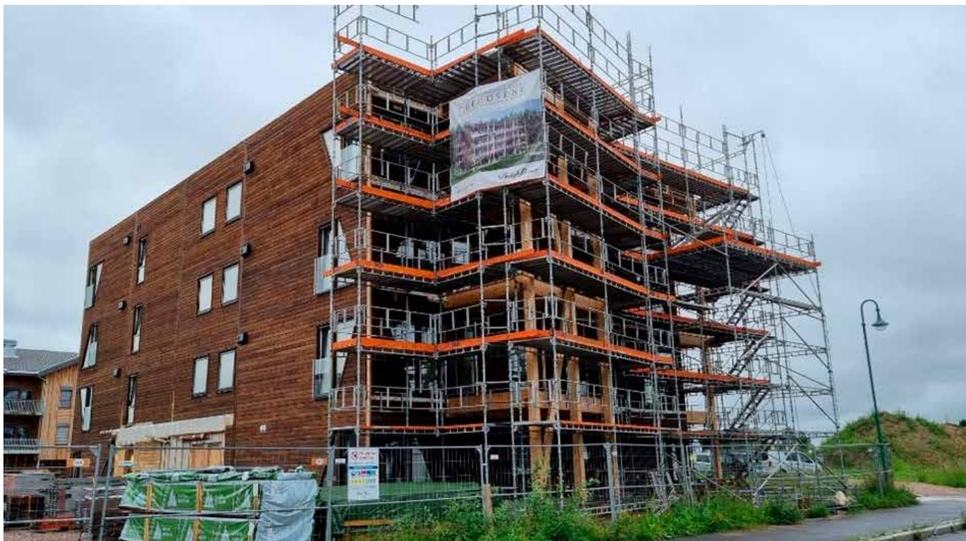
Fasaden tar form. Foto: BoligPartner
