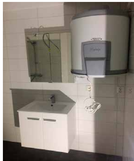
Eksempel på løsning VVbereder på bad. Mulighet for vaskemaskin under bereder.
