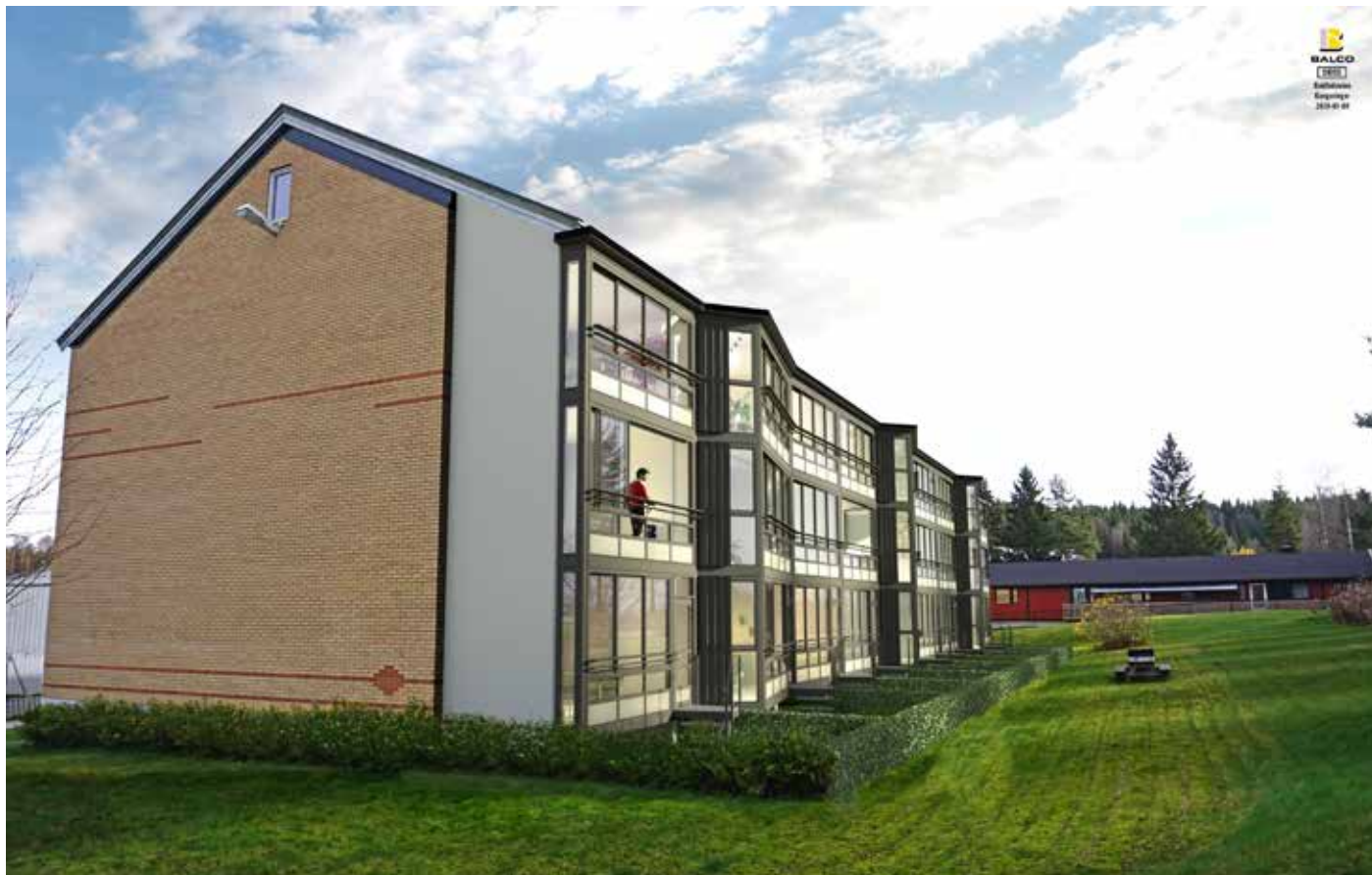
Pent: Arkitekt Pål Jørgensen har tegnet de nye balkongene.
