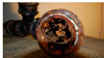
De gamle avløpsrørene renses med høyttrykkspyling (bilde fra Olimb)
