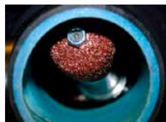
Foringen fylles med glassfiber. Et nytt solid rør bygges opp i det gamle røret. (bilde fra Olimb).
