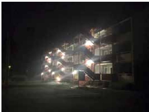
Midlertidig trappehus om kvelden.
