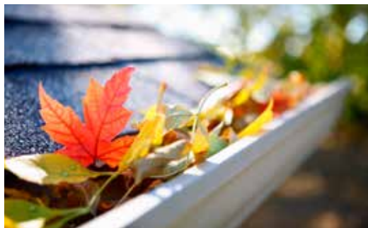
Rens takrenner og nedløp for løv for å unngå vannskade i tak og vegger.
