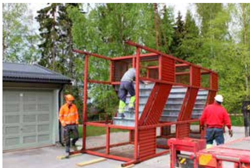
Montering av midlertidig trapp fra balkong.
