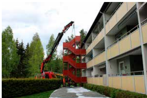
Midlertidig trapp er på plass, bygging av heis kan starte.
